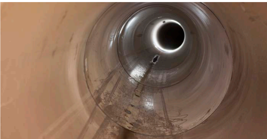
Het inbrengen van de GVK-buis in de koker bleek de oplossing.
