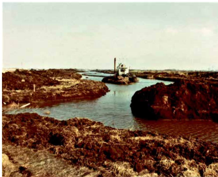
Aanleg van het Schollebos in 1979
